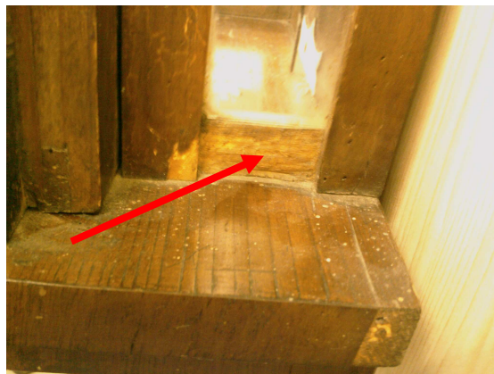
Chybí lišta držící sklo
